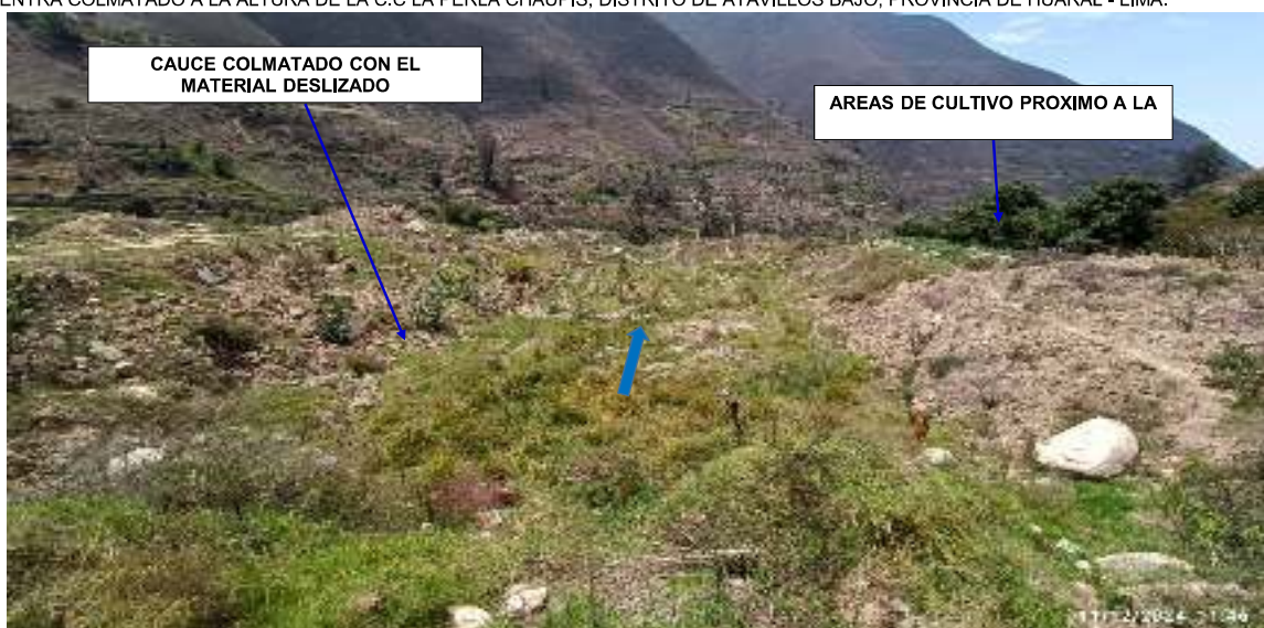
FIGURA N°02: CAUCE COLMATADO CON MATERIAL DESLIZADO CON PRESENCIA DE ROCAS DE DIFERENTES TAMAÑOS EN LA QUEBRADA CUTOPUQUIO, PONIENDO EN RIESGO A DESBORDES HACIA LAS VIVIENDAS DE LA COMUNIDAD CAMPESINA
