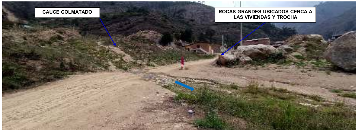
FIGURA N°03: TRAMO DE LA QUEBRADA SE ENCUENTRA COLMATADO CON MATERIAL DE DESLIZAMIENTO EN PARTES HASTA EL NIVEL DE LAS AREAS DE CULTIVO Y LA TROCHA CARROZABLE, PONIENDO EN RIESGO A DESBORDE HACIA LAS VIVIENDAS DE LA C.C. DE LA PERLA CHAUPIS.
